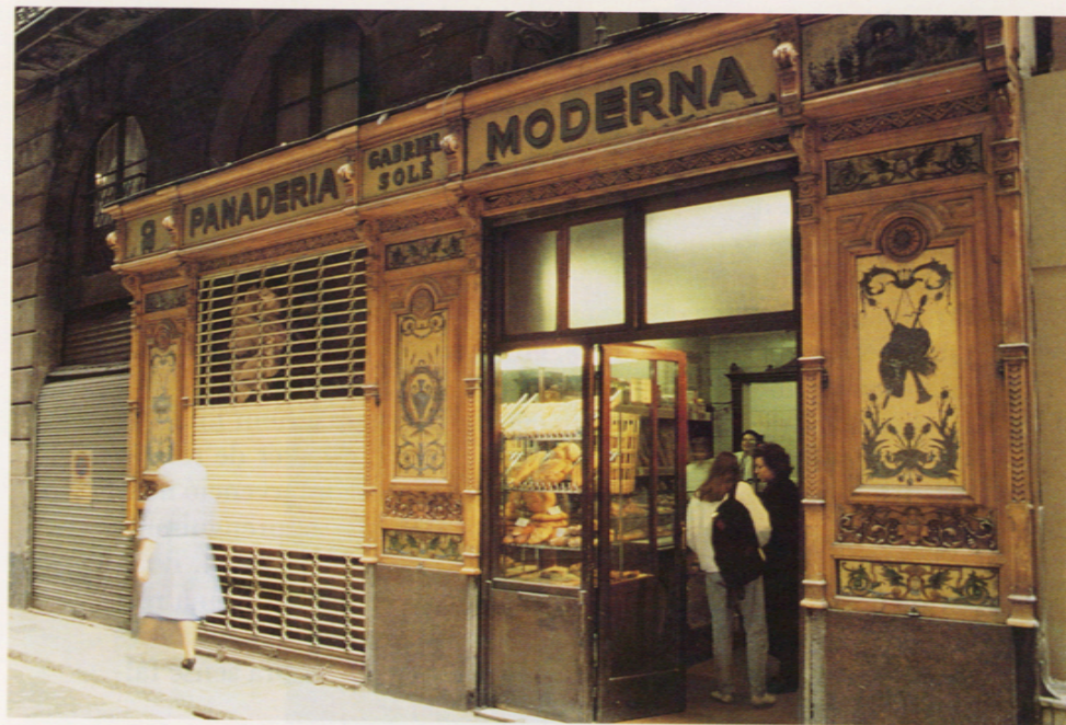
Panaderia Moderna. Un establiment vuitcentista que ha vist recentment mutilat el seu interior (Fot. Rafel Torrella)
